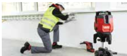
ドア、窓、機器設備等のレベル出し
