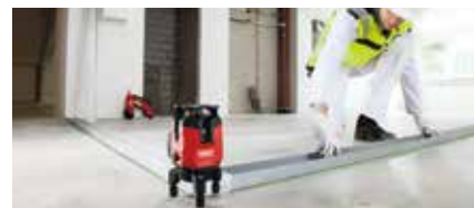
間仕切り壁の設置
