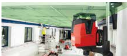
吊り天井の設置
